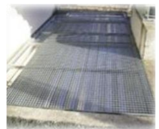
Mise en place des caillebotis
